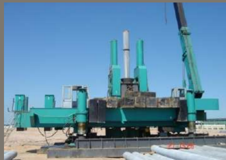
2. Setting of bottom pile and check verticality. 2. Thiết lập cọc đáy và kiểm tra độ ép cọc.
