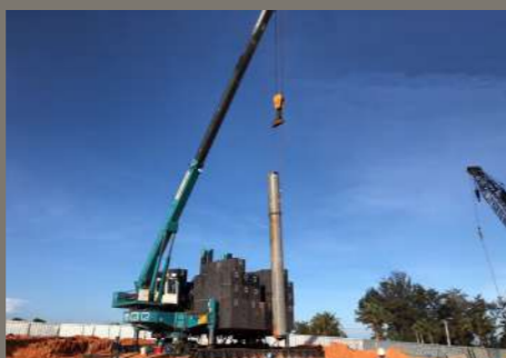
6. Pressing of top pile 6. Ép cọc
