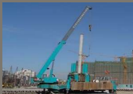
3. Pressing of bottom pile. 3. Công tác ép cọc.
