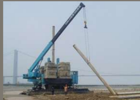
4. Setting of top pile and check verticality. 4. Đưa cọc vào vị trí và kiểm tra và ép cọc.
